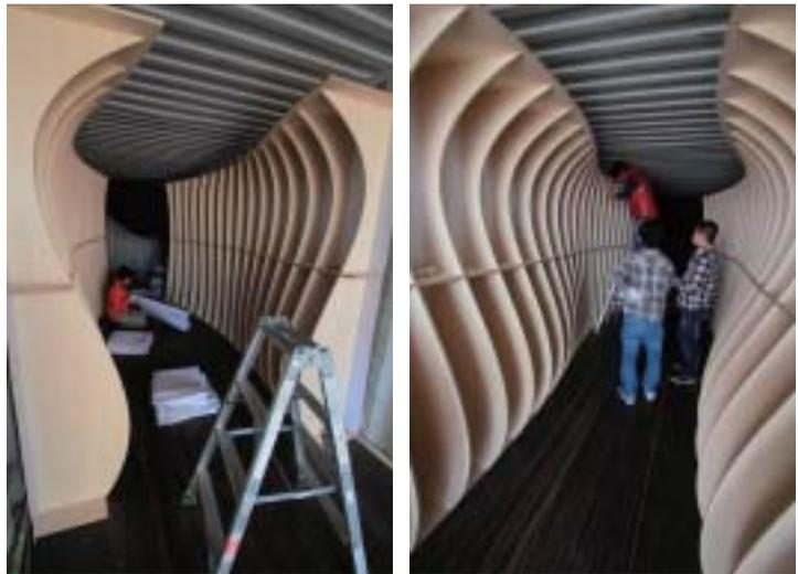
図20・21 積層格子構造の施工現場
